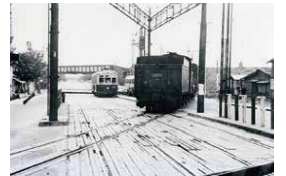
蒲生1丁目の踏切を通過中の蒸気機関車 向こう側で今福行きの市電が待っています。その向こうに京阪電車のガードが見えます。(昭和31年8月)
